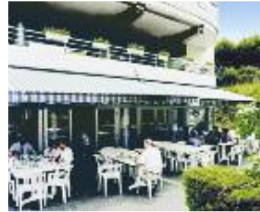
CISP Residenz Kellermann
